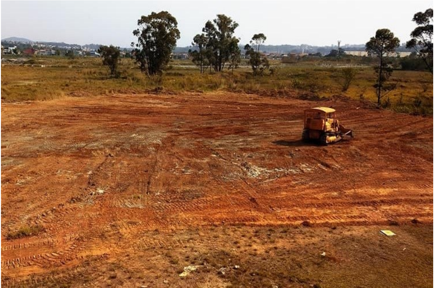
Preparação do terreno para a construção da quadra poliesportiva: previsão de término em 2020
